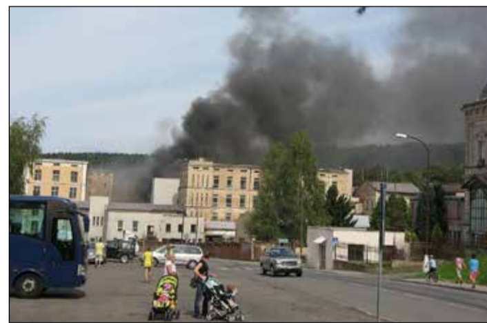
V areálu bývalé Textilany hořelo v roce 2012.
